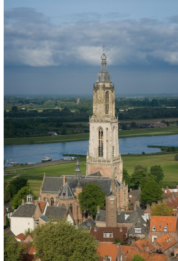
En dit is de Cunerakerk in Rhenen
